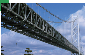
明石海峡大橋
